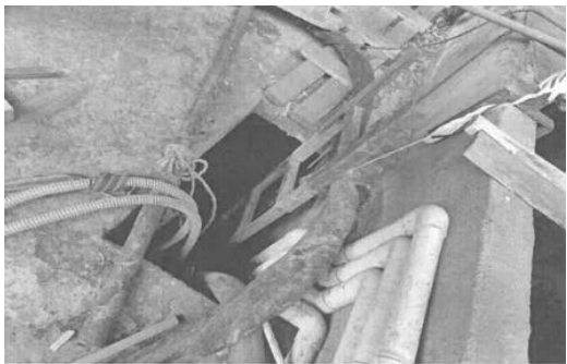
涉事白水收集沉淀池
