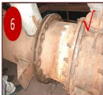
切断装置后人工盲板
