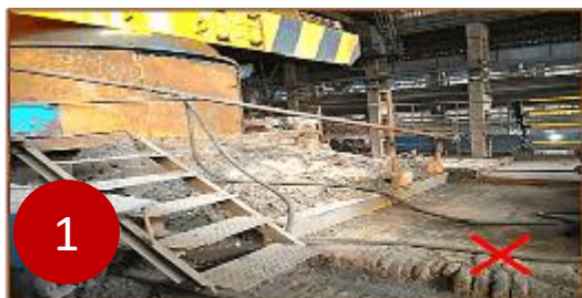
回转事故流槽黄沙填满
