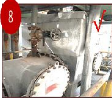
阀腔注水型平行双闸板切断阀
